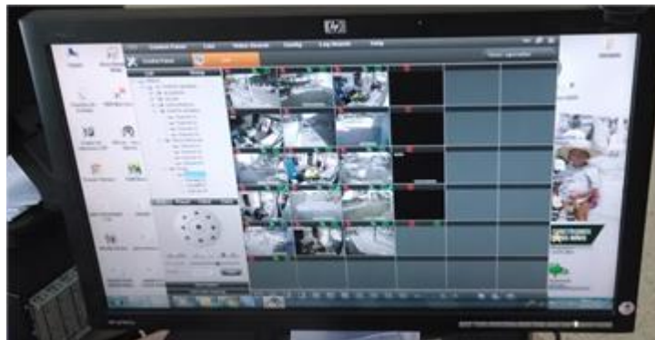
REGISTRÓ FOTOGRAFICO 12 MONITOREO ESTACIÓN DE POLICÍA PUENTE ARANDA
